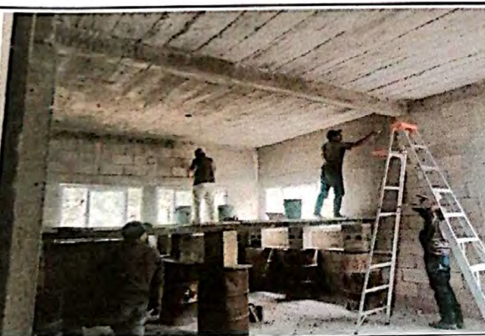
Foto 3: Reparación de repello y cernido de paredes
