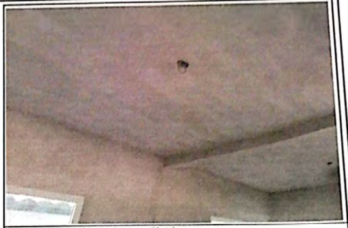
Foto 2: Reparación de sistema eléctrico
