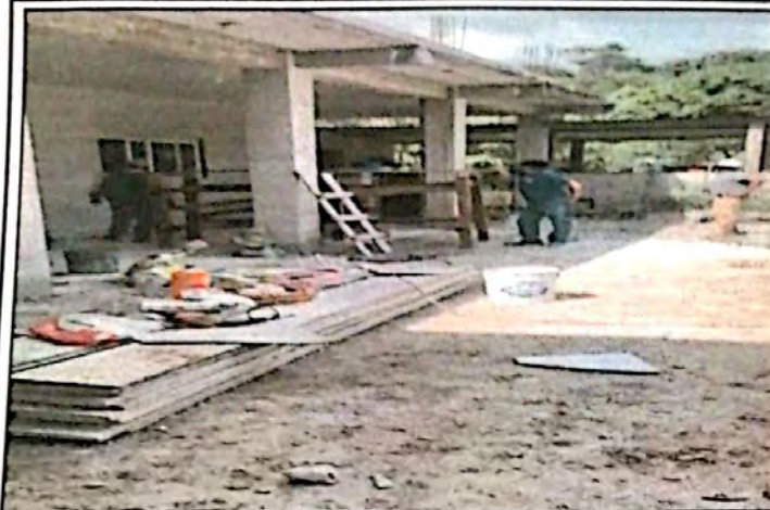
Foto 1: Reparación de repello y cernido de paredes
