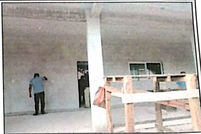
Foto 2: Reparación de repello y cernido de paredes
