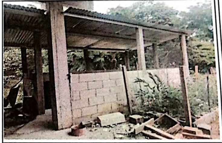
Foto 4: Reparación o sustitución de área de cocina
